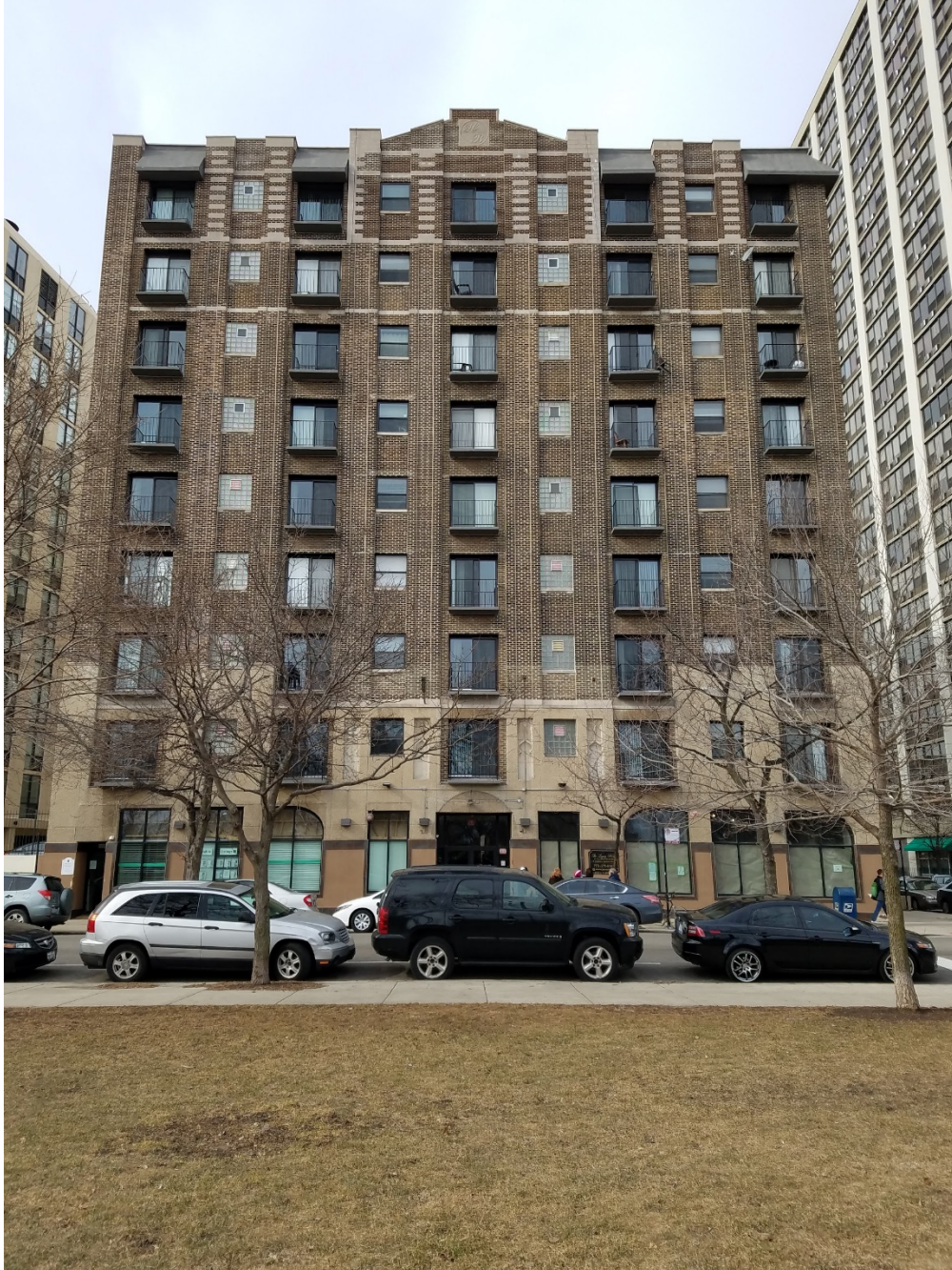
Photo 1 – 4520 N. Clarendon Avenue
